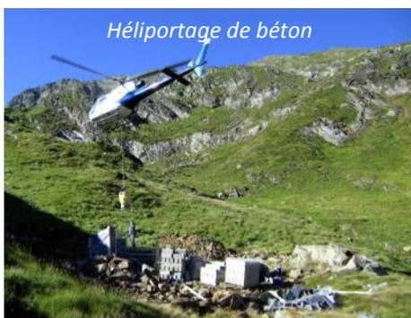
Hélicoptère transportant une charge de béton en vol au-dessus d'un site de construction en montagne.
