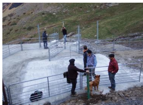
Travaux de mise en place du parc pour la traite
